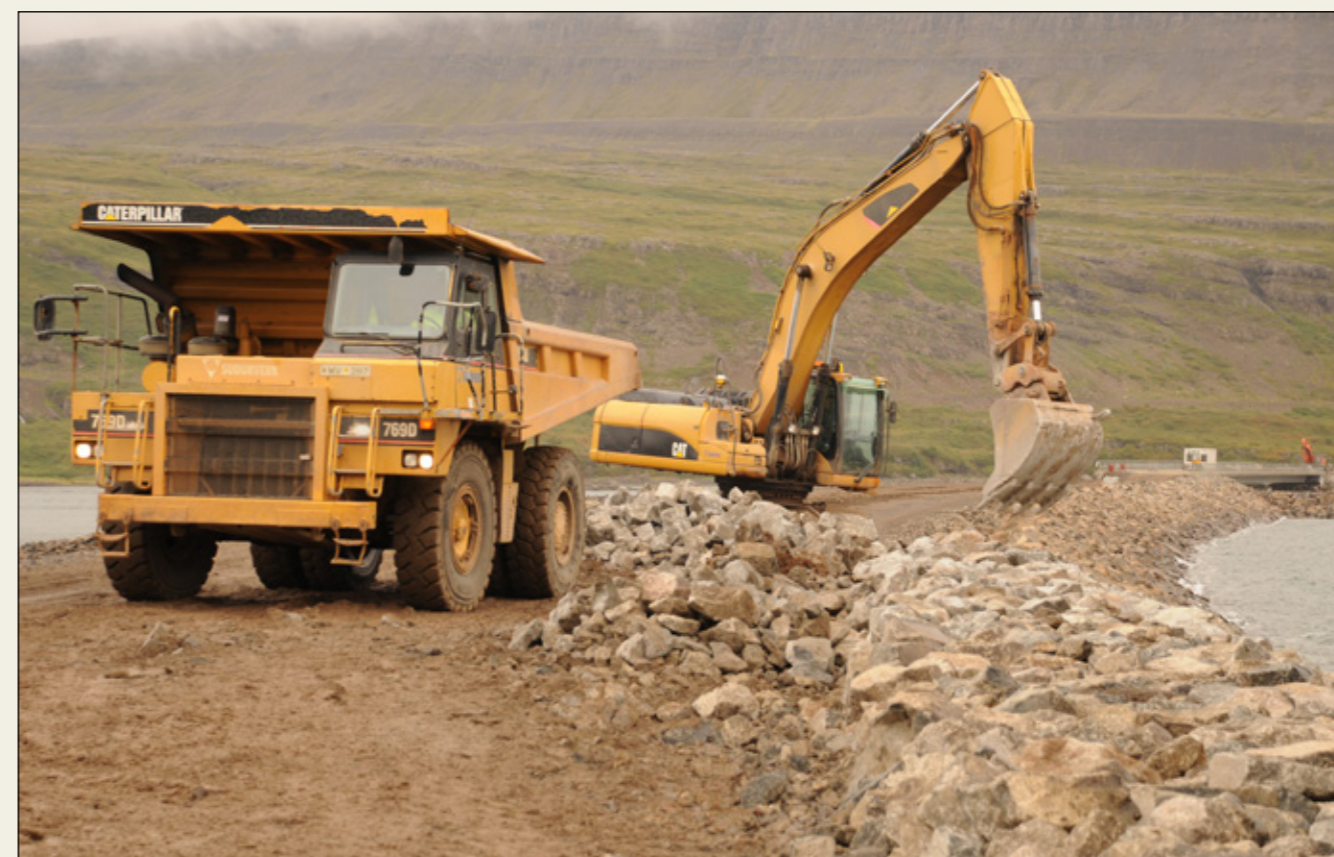
Mynd 2. Rofvörn sett á fyllingu í sjó í Kjálkafirði í Barðarstrandarsýslu árið 2014. Smágrýti, hnullungur, grettistösk og neðri stærðir stórgrýtis.
