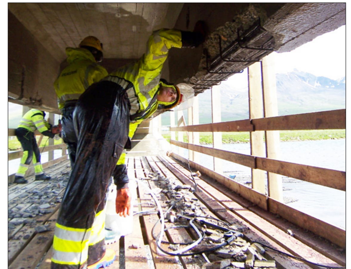
Brúavinnuflokkur Vegagerðarinnar frá Hvammstanga hefur undanfarnar vikur unnið að viðgerð á brúnni yfir Hofsa í Vopnafirði á Hlíðarvegi (917). Myndin var tekin 7. júlí. Þessi brú var byggð 1930 og eru margar brýr af þessari kynslóð komnar á tíma í miklu viðhaldi eða endurnýjun.
